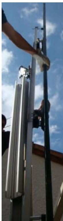
Le **Lève-Vitre CA 400 GL** a été conçu pour faciliter la pose de vitre en toiture de vérandas et en façade. C'est un appareil portable pour une utilisation immédiate sur chantier. La mise en œuvre se fait en moins d'une minute sans aucun outil. Il est composé de seulement 3 éléments : le mât de levage motorisé + le support vitre + les 2 contre-poids (si travail en façade)
