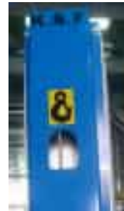
Kabelschutz mit Kranöse
