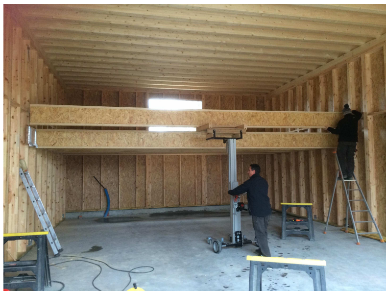
BD 1 mit wood beam 180 kg - 7 m Length
